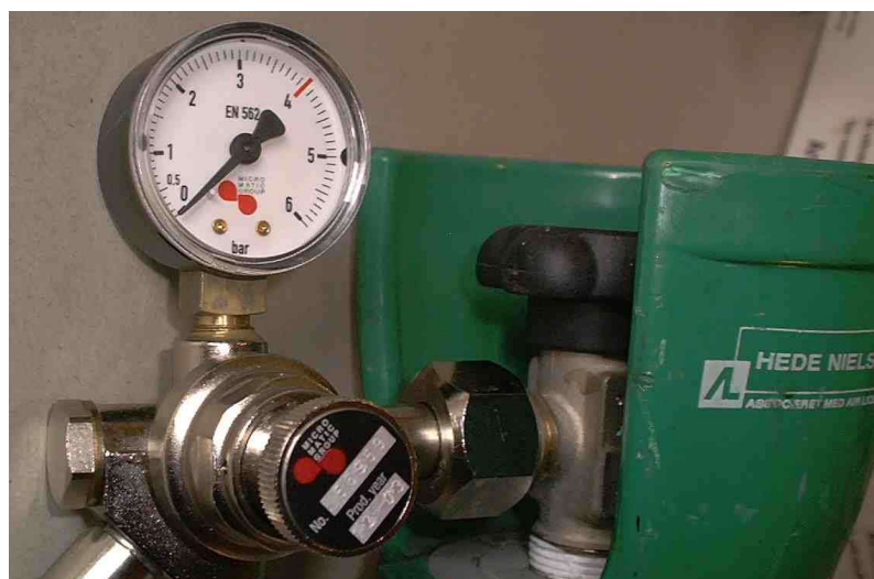
Fig. 1: Trykregulator monteret på stor trykflaske
