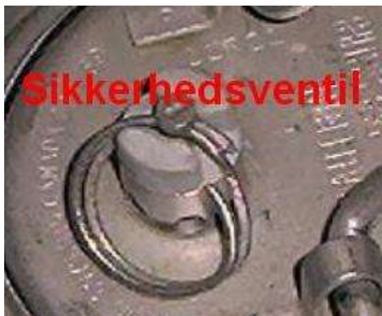
Fig. 2: Udløserring på sikkerhedsventil
